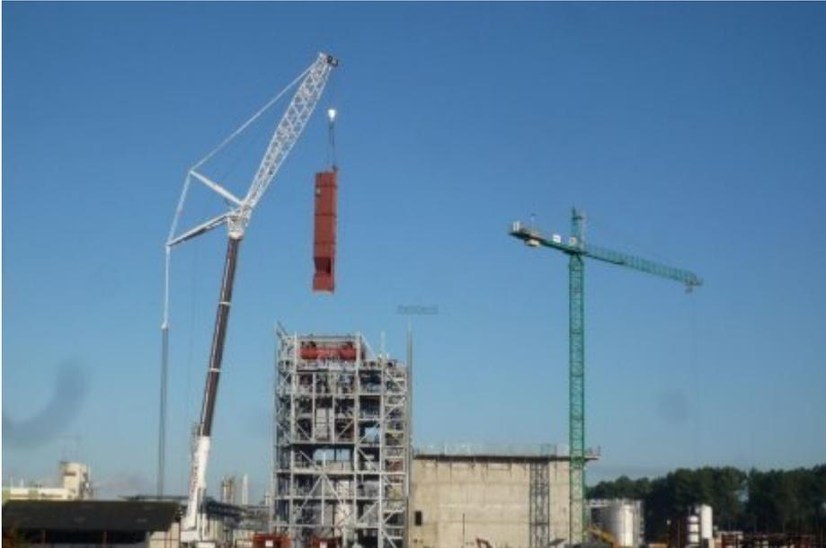
*Un important dispositif de levage a permis la mise en place des gros éléments de la chaudière. (Photo C. Toscas)*
